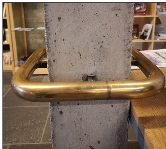
Figur 42. Håndløper rundt bærende søyle i vestibylen. Foto: RDM
