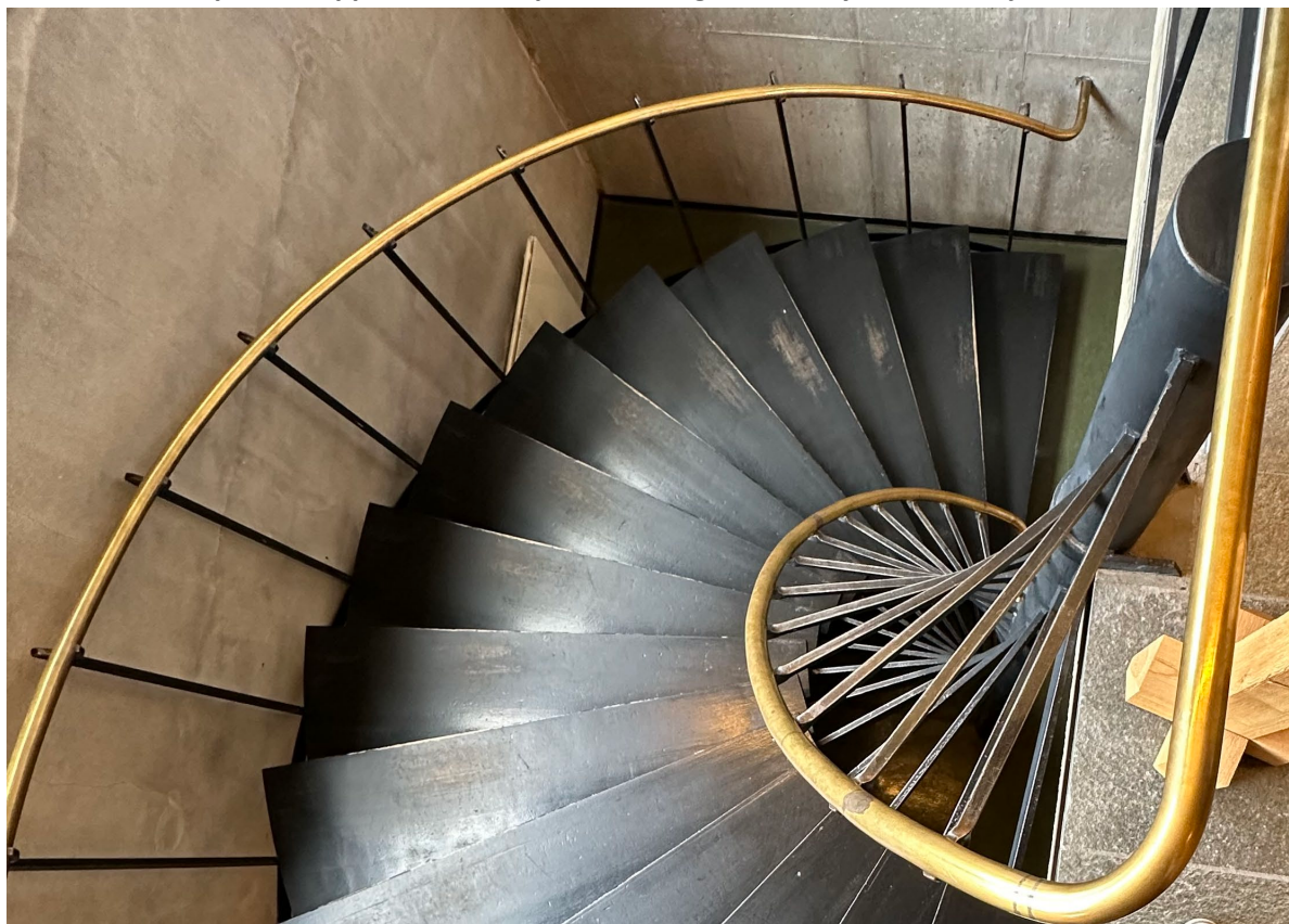
Figur 43. Innendørs spindeltrapp med håndløper fra vestibylen og ned i kjelleren
