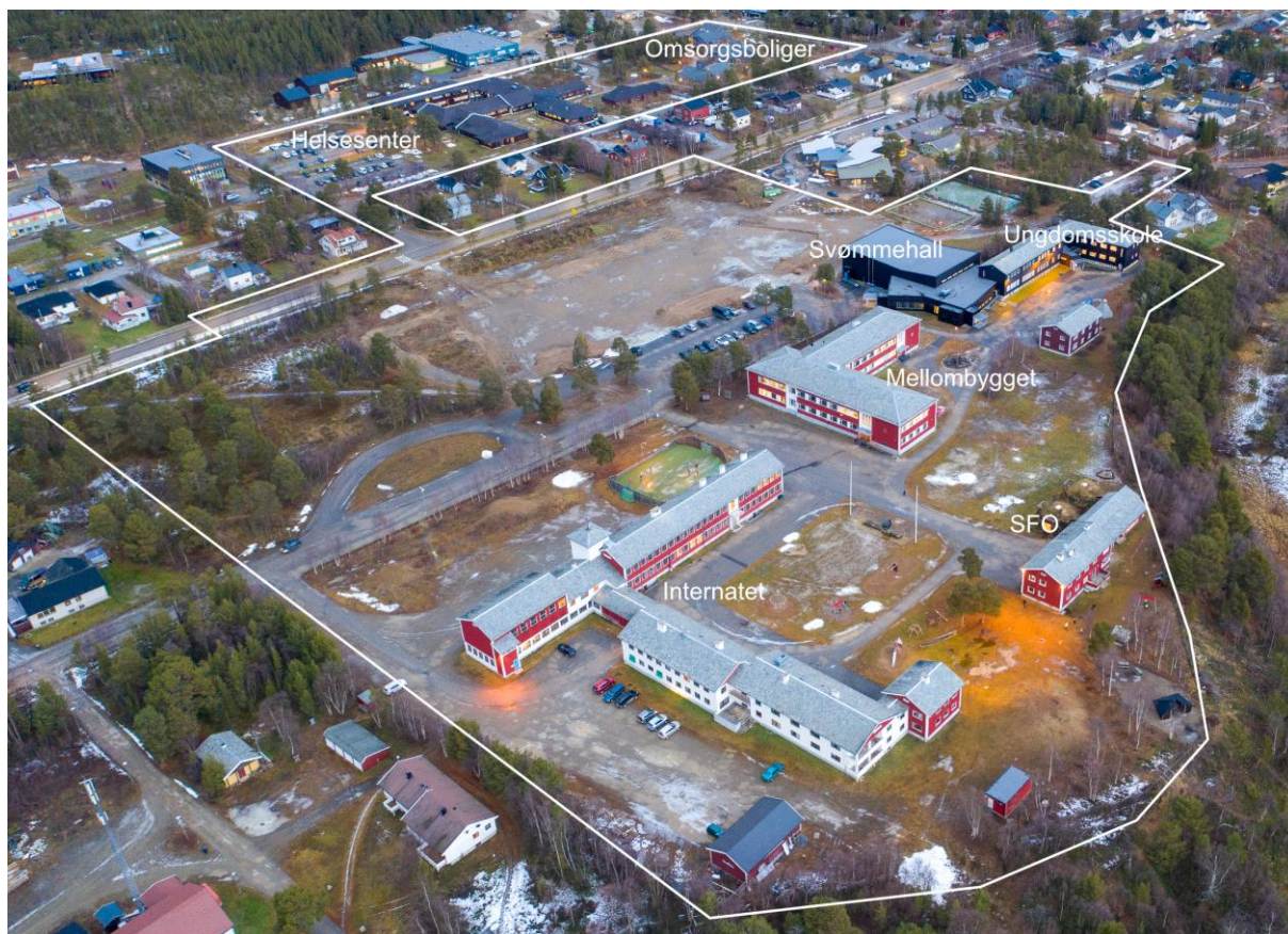
Skråfoto av eksisterende bebyggelse, sett fra nord
