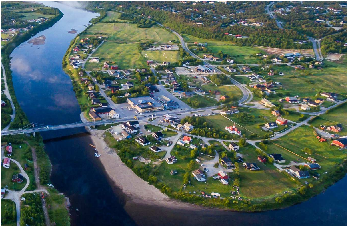
Bilde 6: Bebyggelsen i dag sett fra nordvest mot sydøst (nedover elva). Rv 92 (Suomageaidnu) mot Finland sees midt på bildet. Fv. 223 (Bieskkáŋgeaidnu) til høyre på bildet.
