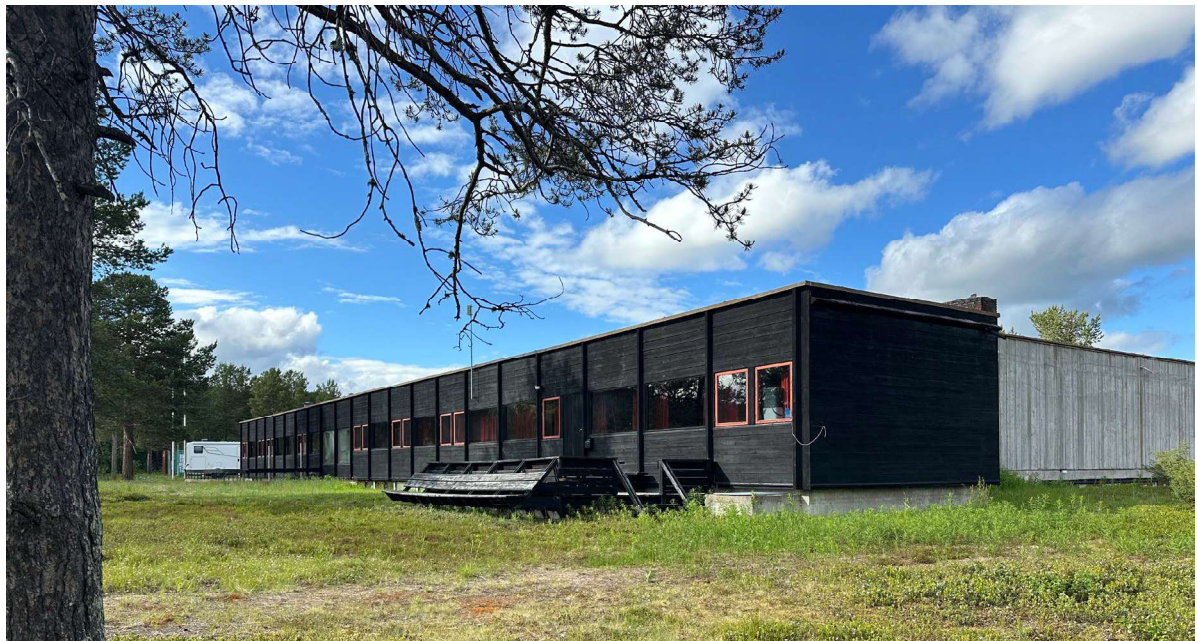
Figur 50 Eksteriørfoto av eksisterende museumsbygning
