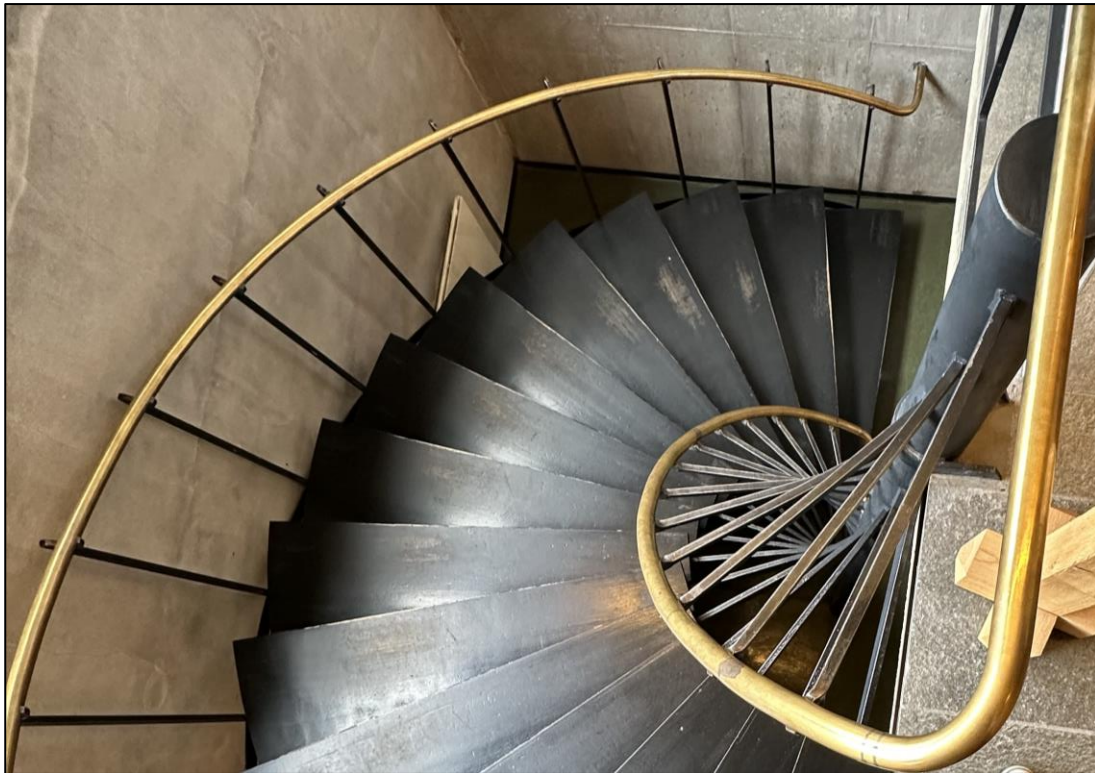
Figur 34: Spindeltrapp med håndløper i messing fra vestibylen ned til kjelleren, formgitt av Iver Jåks.
